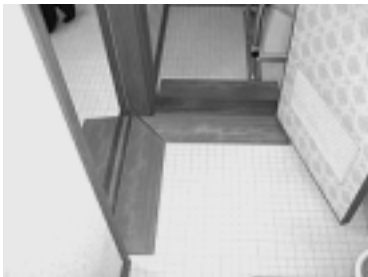
段差解消スロープを使った改修例
